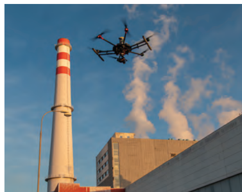
Obr. 8: Ukázka snímání dat na jaderné elektrárně Temelín
